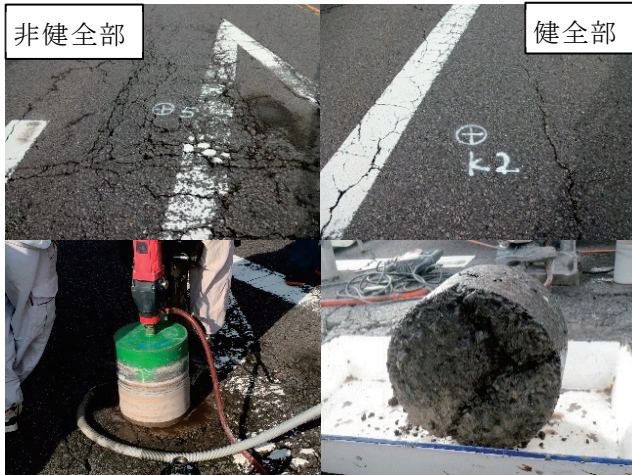
写真-1 路面状態、コア採取の様子
