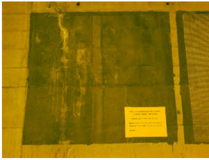
写真-3 施工11年後の状況
