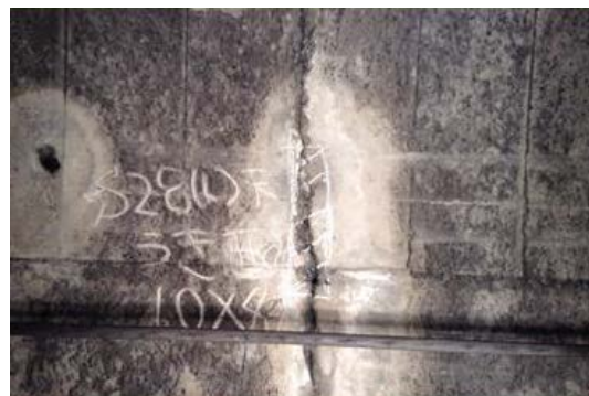
写真-1 横断目地部のうきの例
