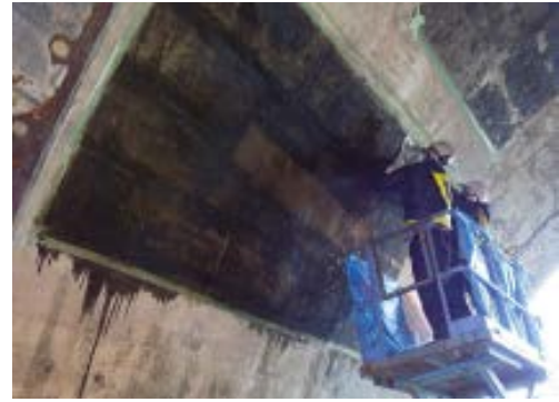
写真-8 NAV-G工法施工状況 高所作業車での施工
