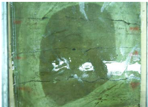
写真-5 NAV工法施工後の可視化状況
