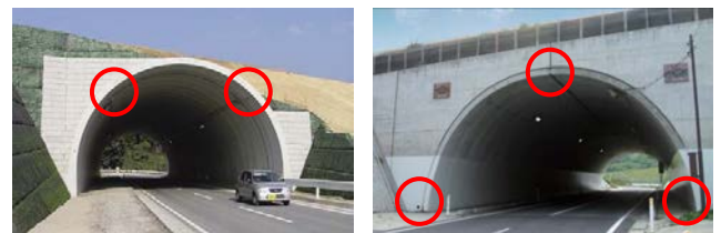
写真-1 ヒンジ式アーチカルバート（赤丸はヒンジ位置）
