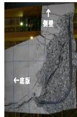
(c) 隅角部損傷（下側）
