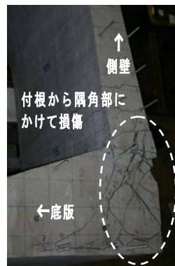
(b) 隅角部損傷（上側）
