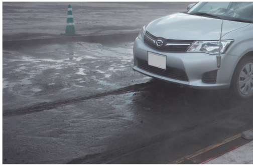
図-4 散水により含水比を大きくした敷設火山灰
