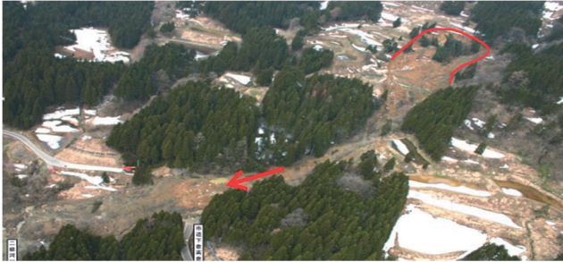
写真-1 ケース「谷」の事例（下倉地すべり）
