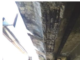
鉄筋の腐食によりコンクリートが剥落
