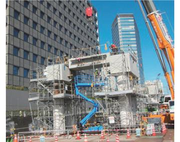
写真-4 ピアキャップ架設状況
