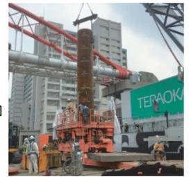
写真-3 回転杭施工状況
