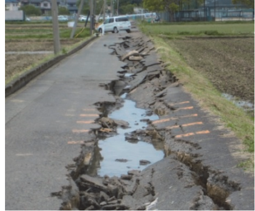
写真-1 下水道管路上の路面陥没(益城町)
