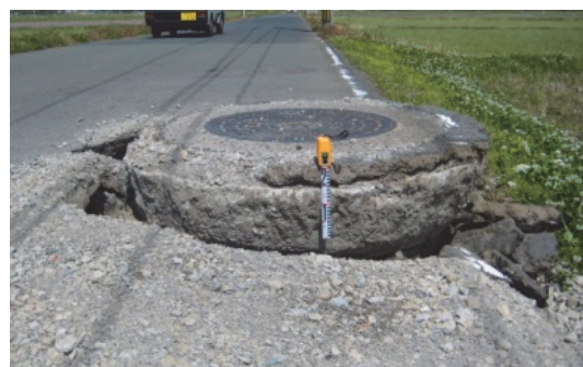
写真-4 マンホール周辺の路面陥没（益城町）
