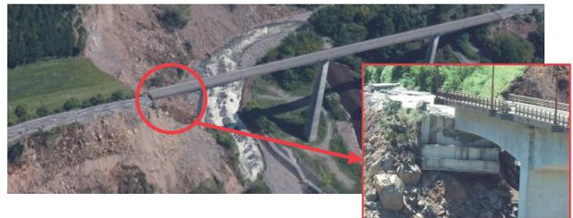
写真-2 斜面変状により機能喪失した橋(阿蘇長陽大橋)
