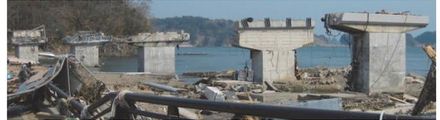
(a) 上部構造が流出して機能喪失した橋
