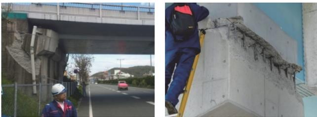
写真-1 変位制限構造の損傷状況<sup>1),2)</sup>
