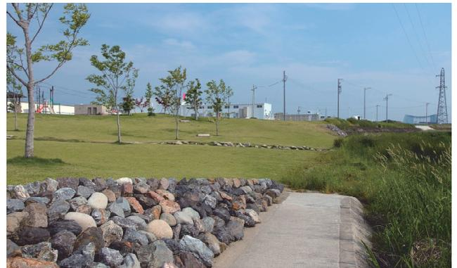
写真-3 護岸端部の処理と堤外水路を利用した園路
