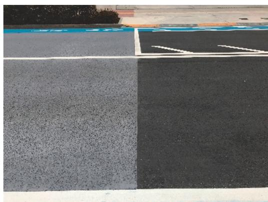
写真-1 遮熱性舗装
