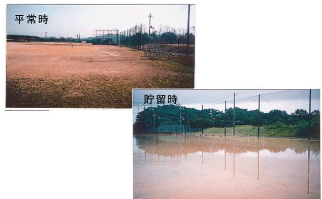
図-3 雨水貯留浸透施設の事例
