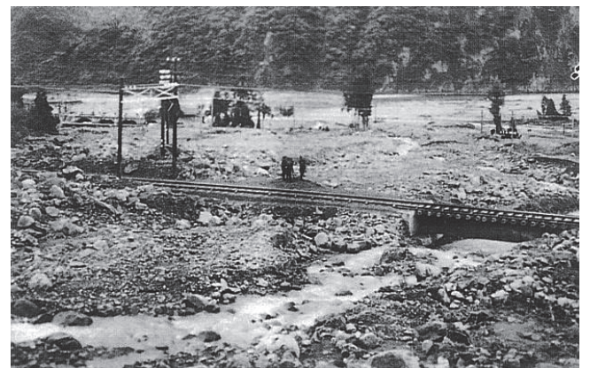
写真-1 被災した鉄道（上越線）（湯沢町）
