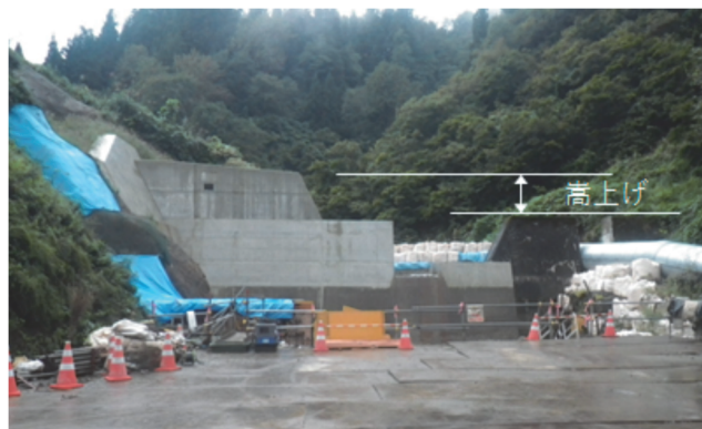
写真-12 既設堰堤の嵩上げ 施工中（相川川 長岡市）
