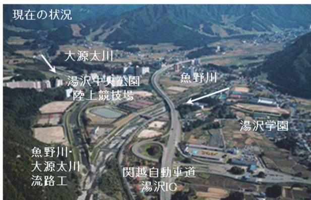
写真-7 流路工整備により発展した湯沢町の様子
