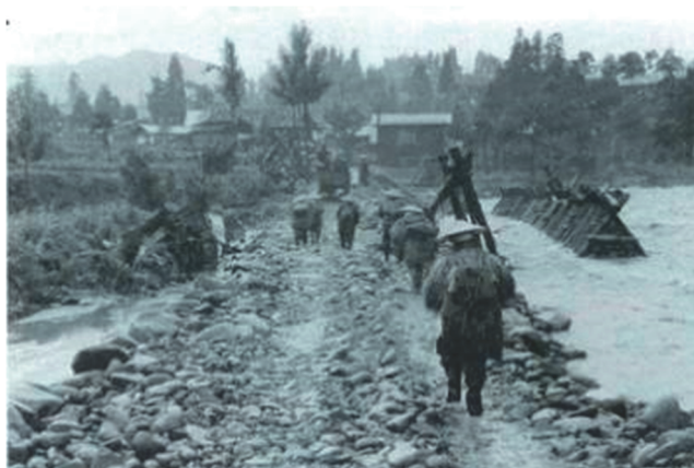
写真-3 破間川流域での氾濫 守門村（現 魚沼市）
