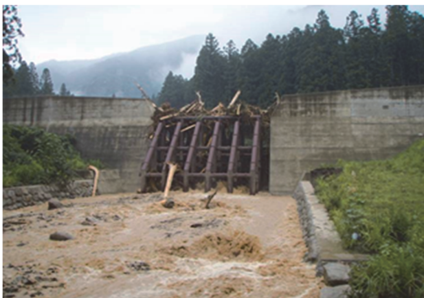
写真-8 土砂流木捕捉状況（H23.7.30）登川支川
