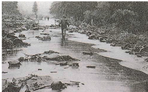
写真-5 登川流域での氾濫 塩沢町（現 南魚沼市）
