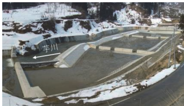
写真-13 遊砂池整備状況（芋川 長岡市）
