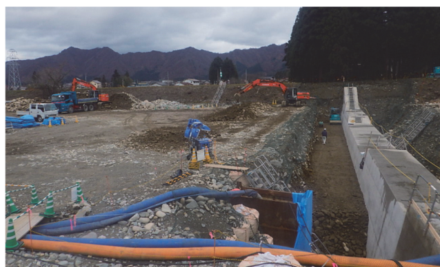
写真-11 河道断面確保（流路工）（登川 南魚沼市）
