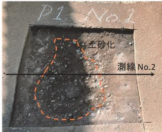
写真-5 舗装開削（土砂化部）
