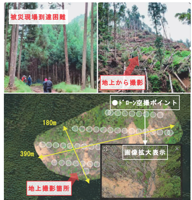
図-6 踏査困難箇所の地滑り調査
