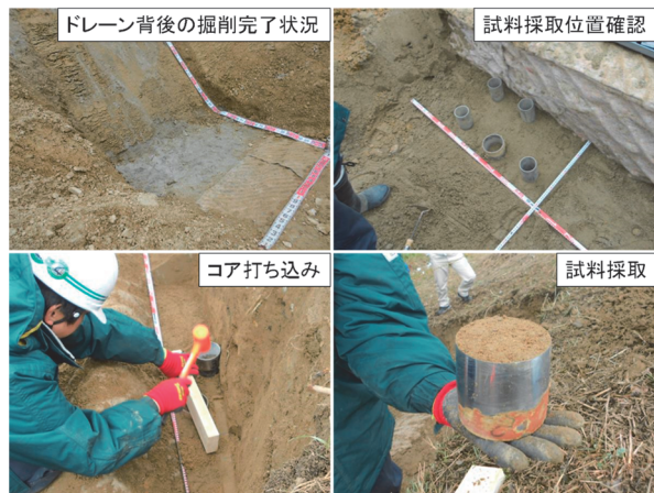
写真・1 土質資料採取状況
