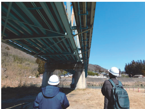
写真-2 穂刈橋の現地調査
