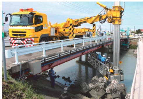
写真-6 古川橋の現地調査
