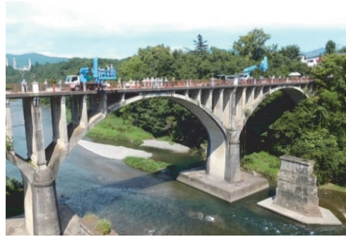
写真-4 秩父橋の現地調査
