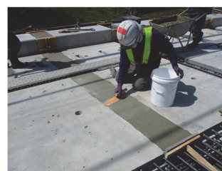
写真-12 間詰部仕上げ状況
