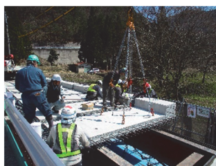
写真-11 床版設置状況
