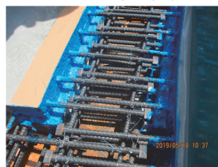
写真-13 接着剤塗布状況
