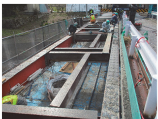
写真-9 床版撤去状況
