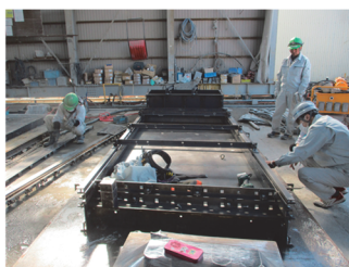
写真-7 型枠製作状況
