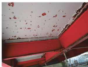
写真-3 床版下面の状況
