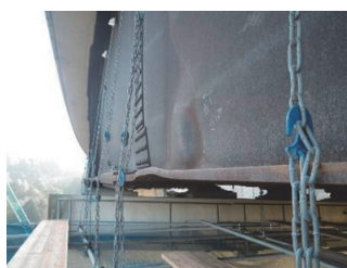
写真-4 主桁径間部の変形（P1-P2径間）
