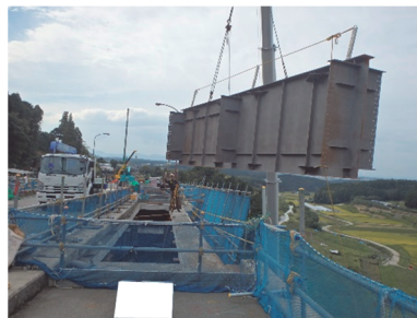
追加桁落とし込み
