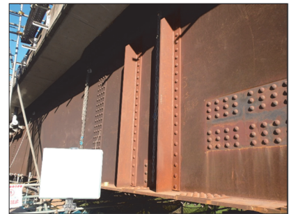
写真-6 主桁支点部への補剛材の追加 (G5主桁 P3橋脚上の支点部)
