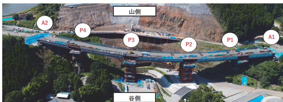
写真-1 大切畑大橋の全景（上部構造を仮設ペントに支持させてジャッキアップし横移動した段階）
