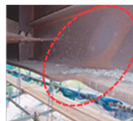
写真-4 主桁径間部の変形（P1-P2径間）
