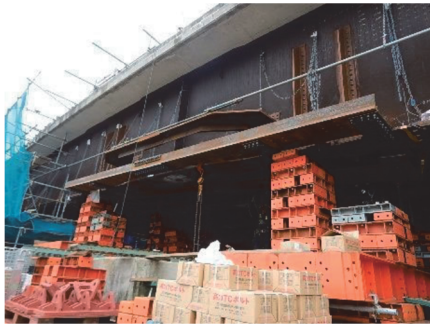
写真-7 主桁中間支点部へのバイパス材の設置
