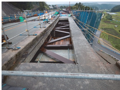
床版の一部撤去
