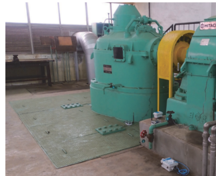
写真-2 排水機場実験で使用した施設
