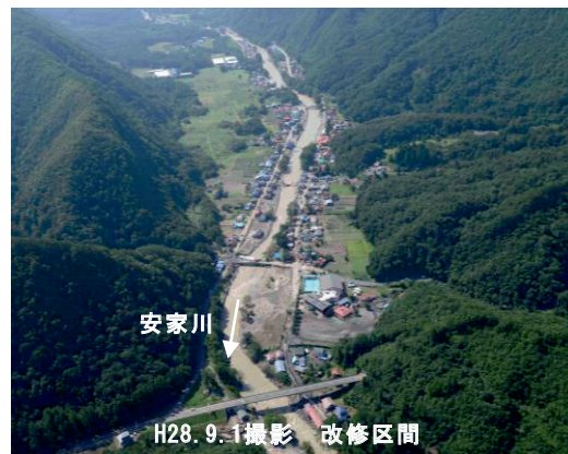
写真-1 安家川の被災状況
