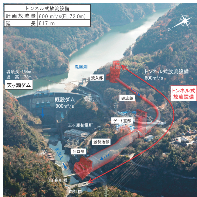
図-1 トンネル式放流設備の概要
