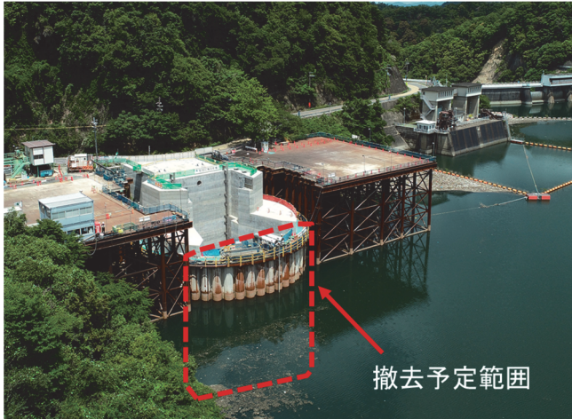
図-8 流入部の鋼管矢板撤去予定範囲
