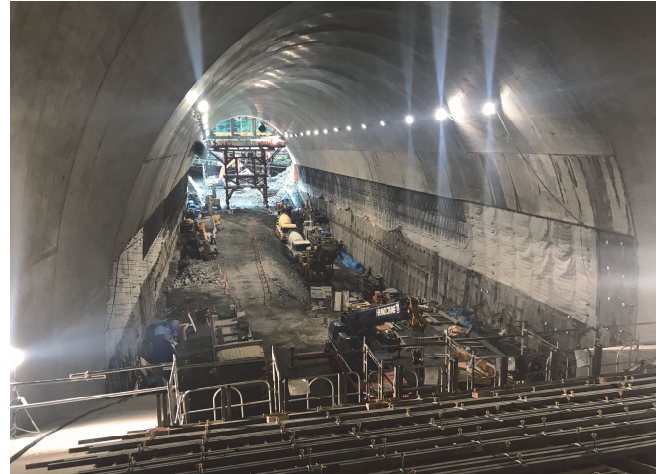
図-9 シュート部の施工状況
