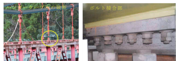
図-3 点検の省力化や信頼性向上の可能性がある部位の例
