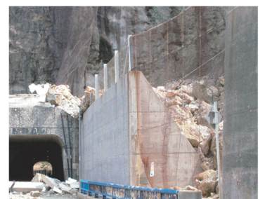
写真-4 岩盤崩壊
