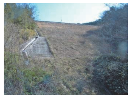
写真-2 高盛土の状況
