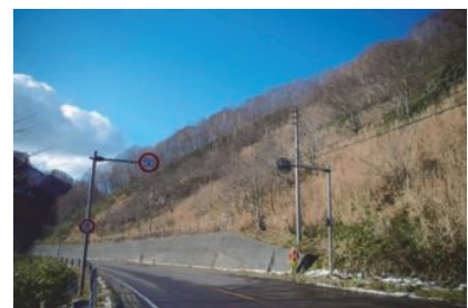
写真-1 長大切土の状況
