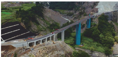
写真-1 阿蘇長陽大橋（復旧工事中の状況）
