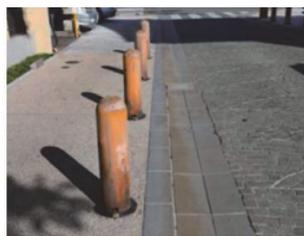
写真-1 使い勝手に配慮した横断構成：セミフラット形式の歩道（左）と着脱式のボラード（右）
