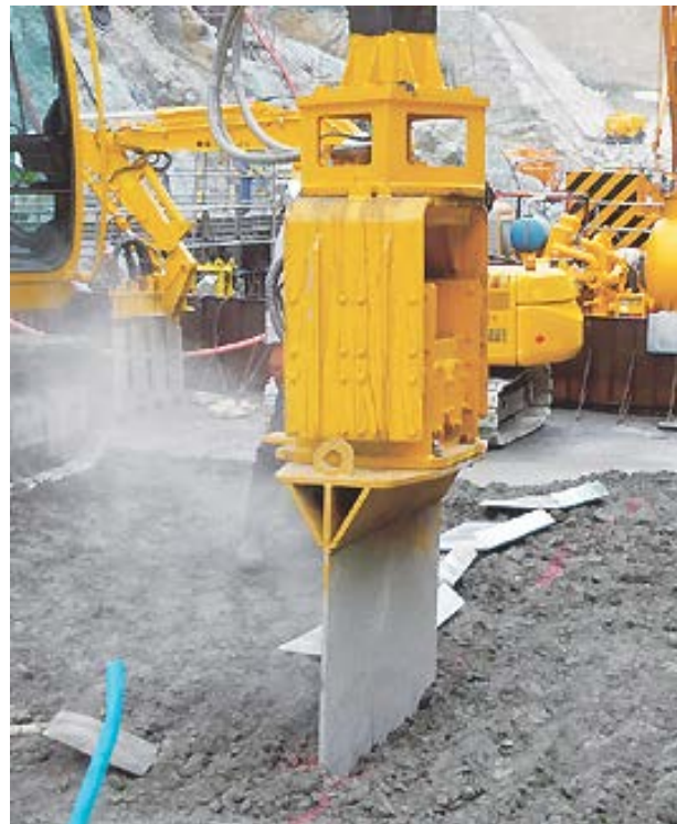
写真 RCD工法による重力式コンクリートダムの横継目設置状況
